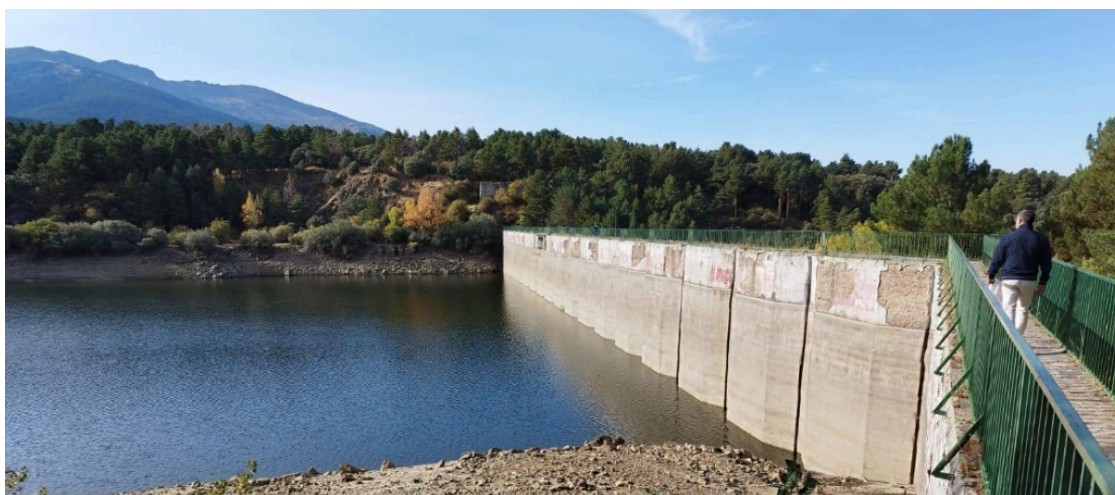
Embalse de Puente Alta, en Segovia Ayuntamiento de Segovia
