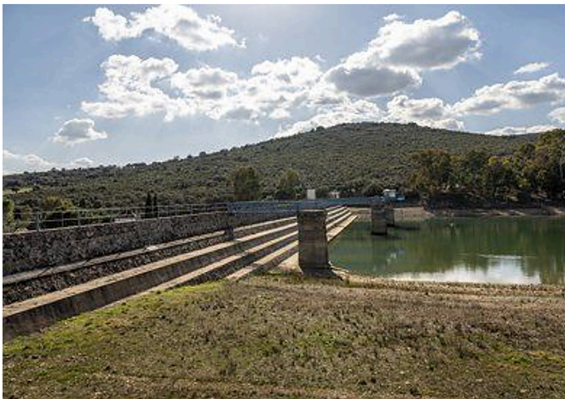
La ampliación se articulará mediante dos ramales que conectarán con la Tubería Manchega. (ABC)
